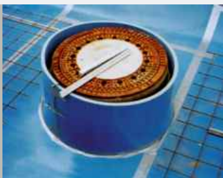
Aislamiento de un sistema de losa flotante frente a una canalización
